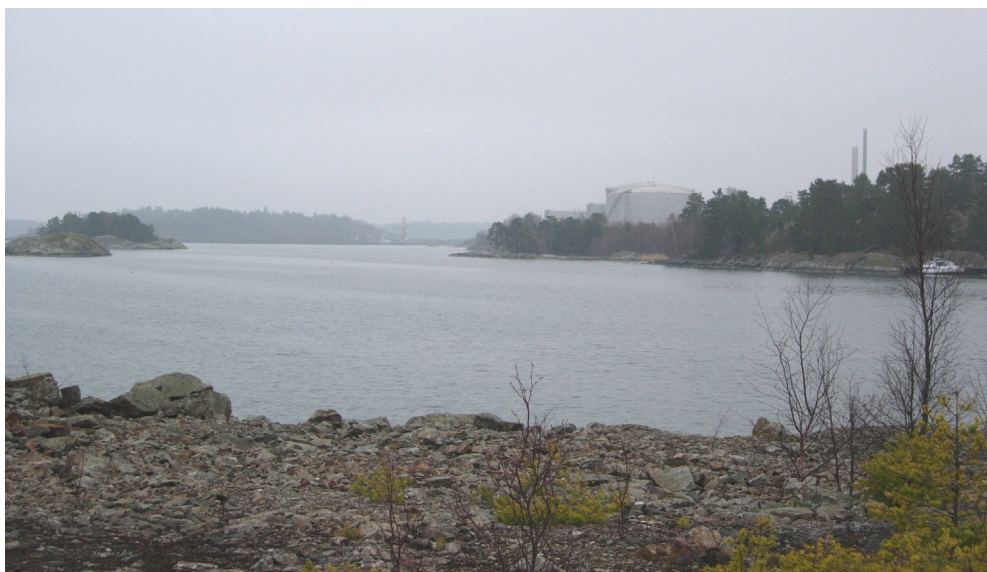
Foto 1. Nynäs Refinings norra lagringscisterner norrifrån sett från (utfyllnaden) vid Utterviken.
